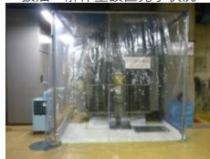
抜油・解体室設置完了状況
