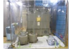
解体完了実施状況
