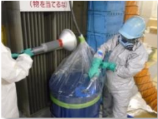
抜油実施状況（局所排気システム稼働） （物を当てる等）
