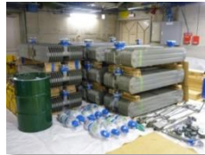
解体完了実施状況
