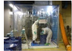
抜油実施状況（活性炭排気システム稼働）
